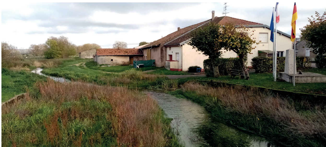
Des travaux ont été réalisés sur le ruisseau du Terrouin en traversée d'Andilly.
