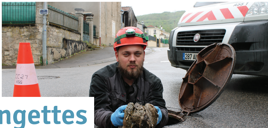
Les lingettes, agglomérées en paquets, doivent être retirées manuellement (Florian Retailleau, agent assainissement)
